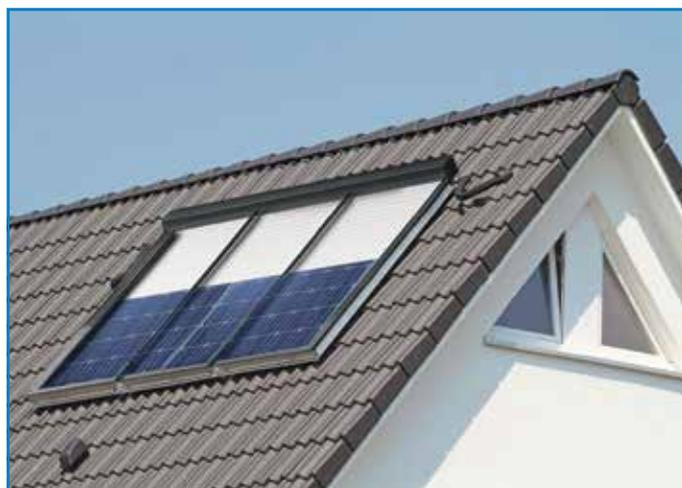
Sie lassen sich je nach Sonneneinstrahlung und Wärmebedarf runter- und wieder hochfahren und individuell steuern. Man kann so zum Beispiel von drei Kollektoren nur einen oder zwei Wärme erzeugen lassen. In der Urlaubszeit, wenn die Wärme gar keinen Abnehmer findet, sollten die Rollläden ganz geschlossen bleiben. Die Rollladensysteme schützen zudem auch vor Hagel. *pr-jaegerl www.rollladen.de*
