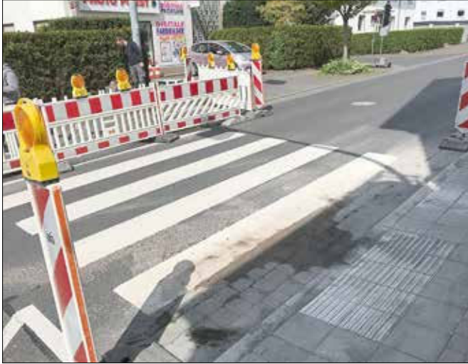
Absenkung des Bordsteins am Zebrastreifen in der Fuldaer Straße in Eichenzell
