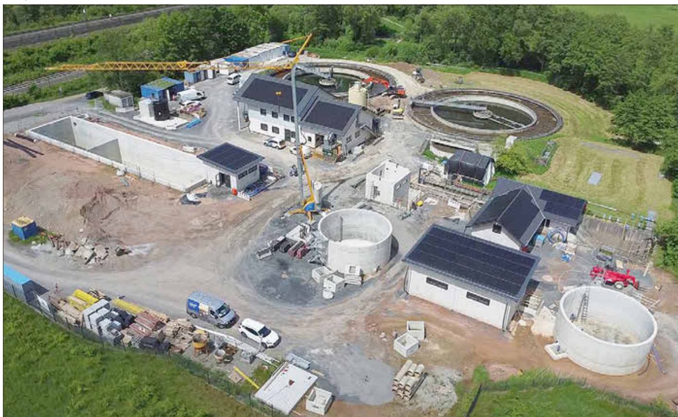
Das Gelände der Kläranlage Löschenrod während der Umbaumaßnahme aus der Vogelperspektive.
