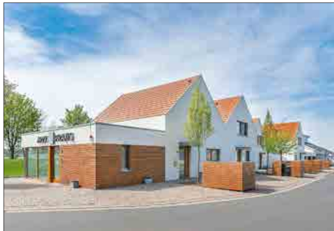
Ein weiterer Gewinner aus dem Wettbewerb 2021: Am Ortsrand von Dipperz hat Dr. Hölper eine Wohnhausbebauung mit drei Wohngebäuden, einer Arztpraxis sowie einer Garage mit vier Stellplätzen errichtet. Die drei Wohngebäude sind als Einfamilienhäuser errichtet worden. Staffelung der Baukörper, weißer Außenputz, rote Ziegel und Holzverkleidung: Der Gebäudekomplex ist typisch für die Region. Foto: Dr. Hölper
