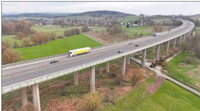
A7 TB Welkers Blickrichtung Süd Foto: Die Autobahn GmbH des Bundes
