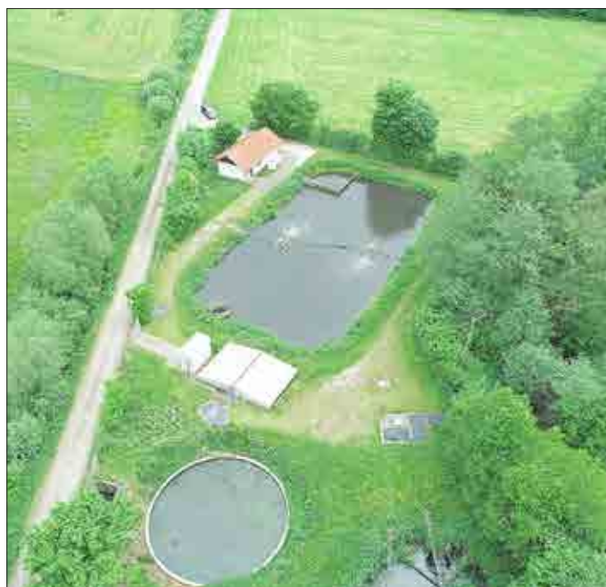
Luftbildaufnahme der Kläranlage Weyhers
