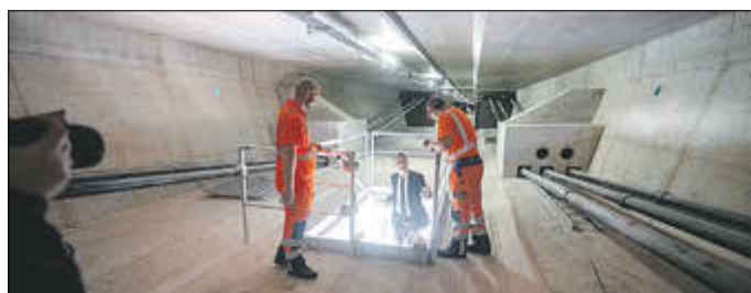
Die neue Brücke besteht aus einem Stahlbeton-Hohlkasten, den man betreten kann.
