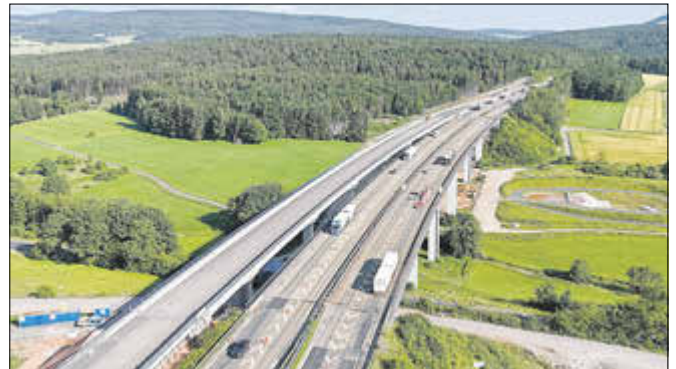
Die alten Teilbauwerke der Talbrücke Thalaubach werden am 15. März gesprengt. Links ist bereits das neue Teilbauwerk der A7 zu sehen.
