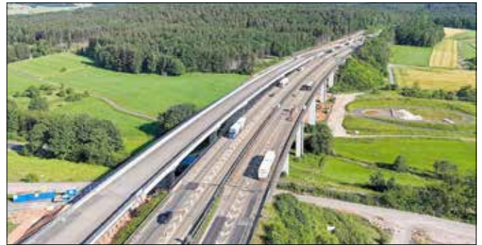
Die alten Teilbauwerke der Talbrücke Thalaubach werden am 15. März gesprengt. Links ist bereits das neue Teilbauwerk der A7 zu sehen.
