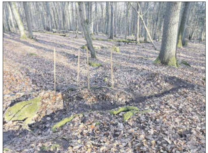
Beispiel für die händische Verbauung einer Erosionsrinne. Das Wasser verbreitet sich so wieder im Eichenbestand.
