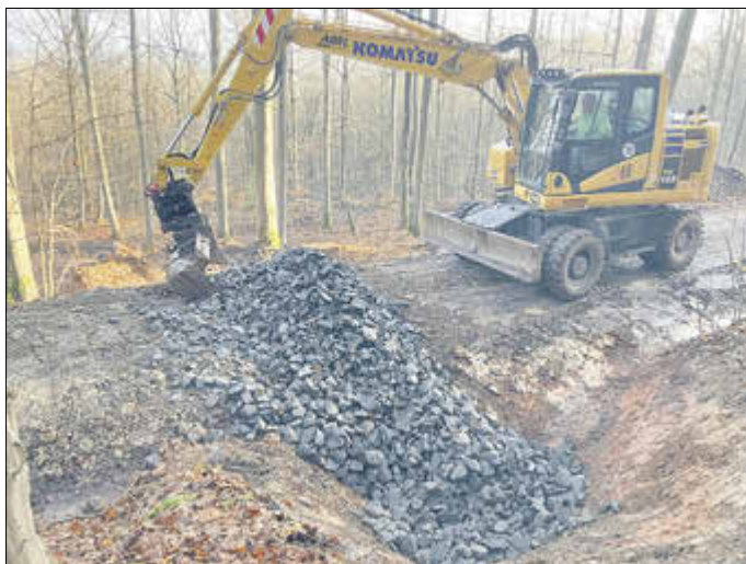
Bau einer Rigole durch die Firma Abel
