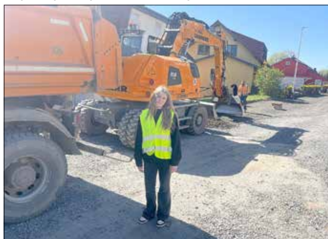
Lenia Dorn bei der Begehung der Baustelle „Am Steinberg“ in Kerzell
