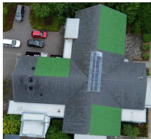
PV-Anlage BGH Welkers
