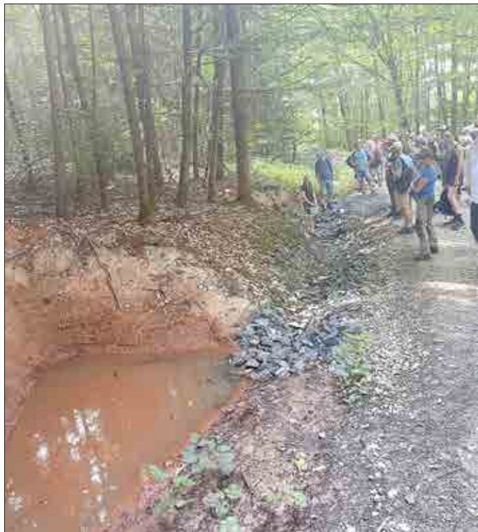
Sophie Hartmann erklärt anschaulich die Funktionsweise einer angelegten Rigole und wie dadurch bei Starkregen weniger Wasser in die Orte gelangt.
