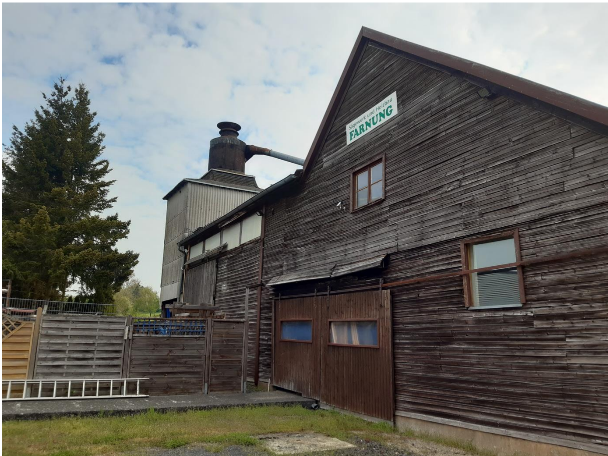
Abb. 2: Ansicht der abzureißenden Gebäude (hier Bereich des alten Sägewerks) von Westen aus – weitere Fotos s. Anhang
