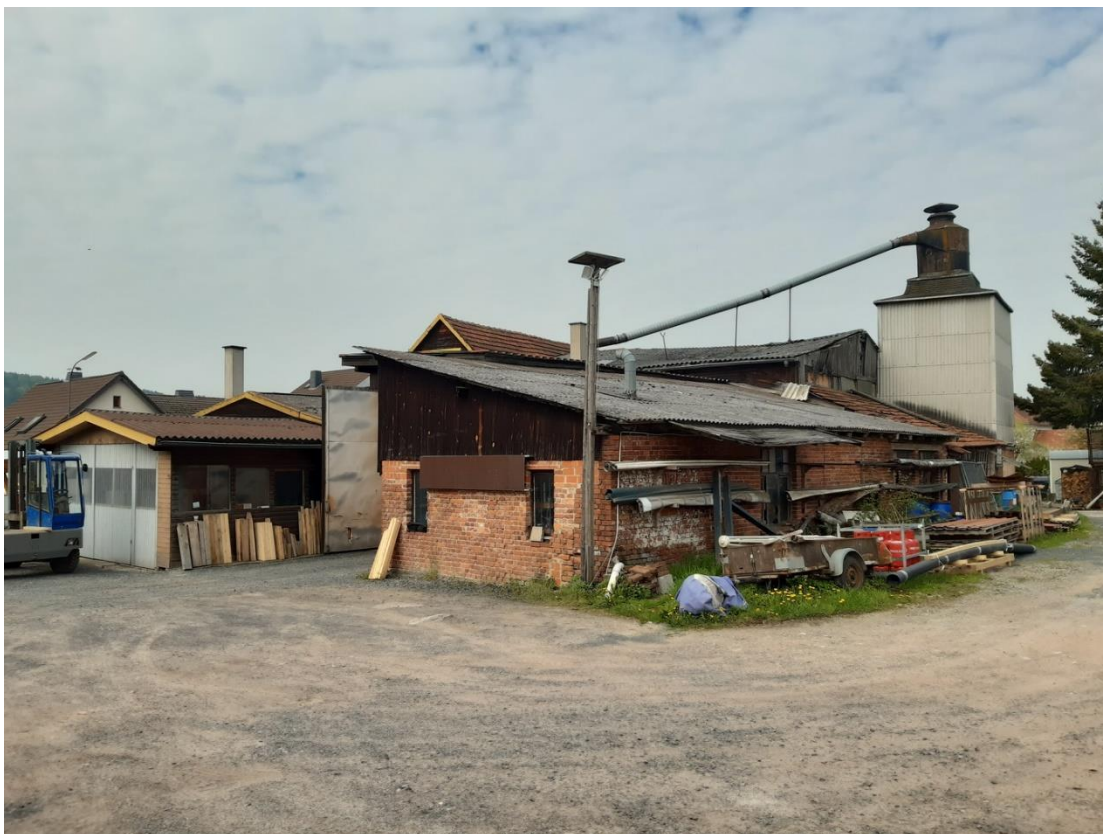
Abb. A2 Blick auf das Sägewerksgebäude von Nord-Osten aus
