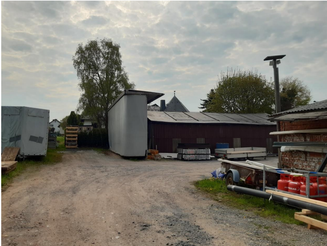
Abb. A3: Blick auf die zusätzlich abzureißende Lagerhalle
