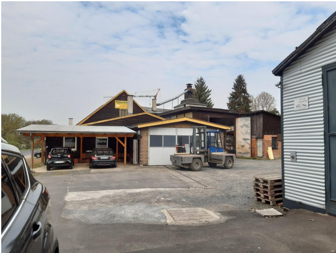
Abb. A1 Blick auf das Sägewerksgebäude von Süd-Osten aus
