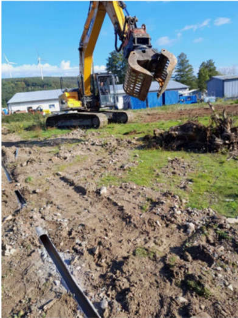
Eingegrabene Rinnen nehmen flüchtende Eidechsen bei behutsamen Räumarbeiten auf. Dieses System wurde vom Verfasser entwickelt und 2022 erfolgreich getestet.
